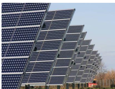
Mesure : Installer des panneaux solaires
